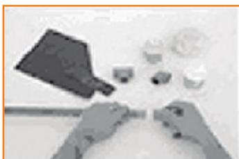
Paso 4: Encaje de una vez las extremidades que se vayan a soldar, promoviendo, en cuanto encaje, un leve movimiento de rotación entre las piezas 1/4 vuelta hasta que alcancen la posición definitiva. Encajar las partes y remover cualquier exceso de adhesivo y espere 1 hora para llenar la tubería de agua y 12 horas para hacer la prueba de presión.
